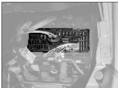
Предохранители в моторном отсеке
